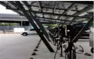
7KW交流充电桩 7KW AC Charging Pile
